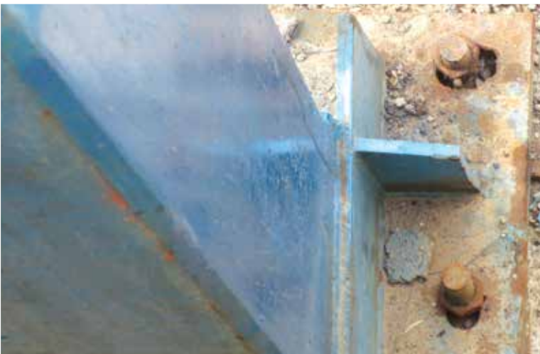
اجرای نامناسب Plate و بولت های آن
