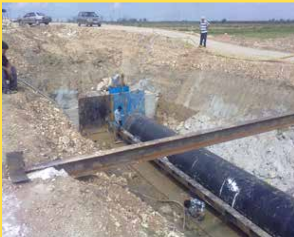
شکل شماره ۴: اجرای عملیات لوله رانی
