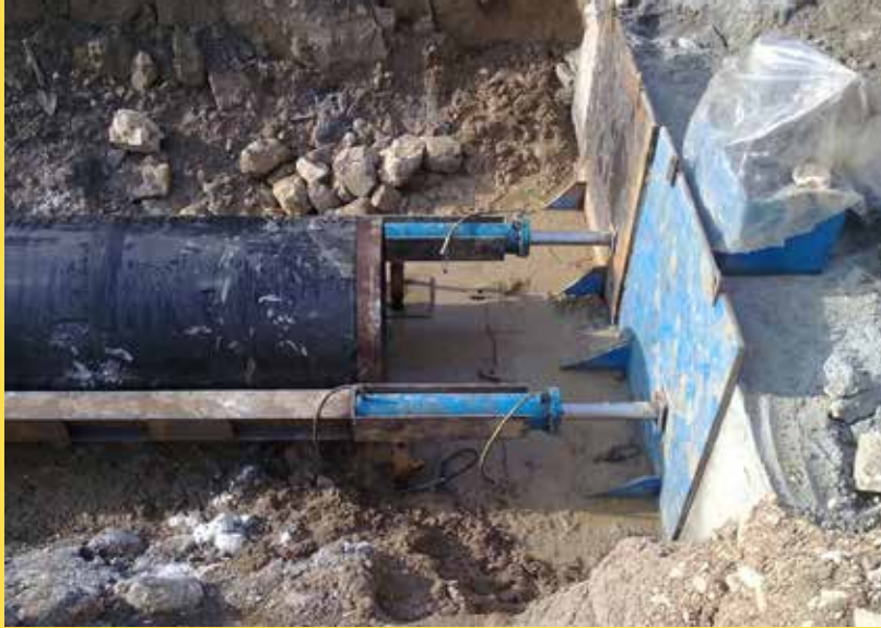
شکل شماره ۱: دیواره عکس العمل و نصب جک و بازوهای هدایت
