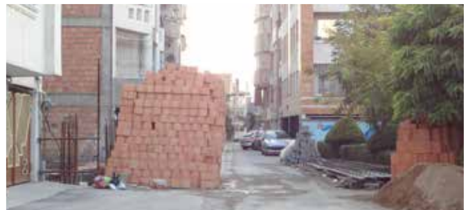
استفاده نادرست از حریم خیابان به عنوان محوطه کارگاه و عدم رعایت اصول ایمنی
