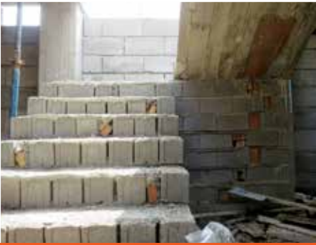
عدم اتصال دال پله با فونداسیون و استفاده از بلوک سیمانی به عنوان راه پله
