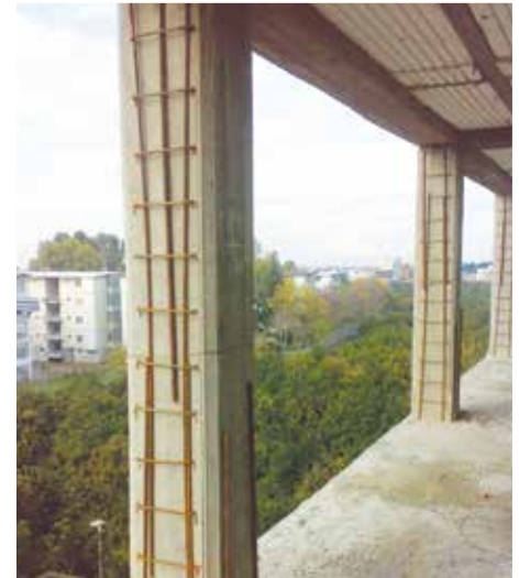
تقویت و مقاوم سازی نامناسب ستون ها پس از اجرای آن ها
