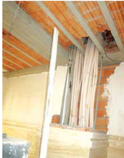
عدم احداث داکت مناسب جهت تاسیسات برقی و مکانیکی
