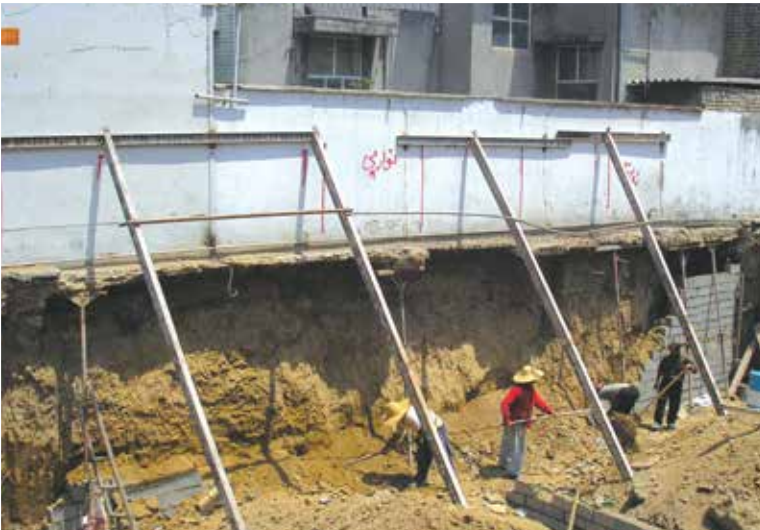
اجرای نامناسب سازه نگهدارنده و خطر ریزش دیوار همسایه
