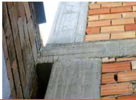
خروج از مرکزیت ستون ها در طبقات ساختمان
