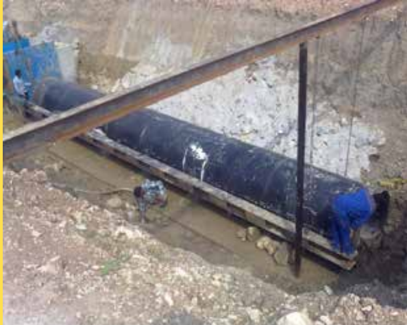
شکل شماره ۲: عملیات جاگذاری لوله
